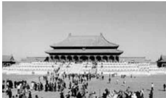
胡宮 大和殿 雨水を生かす
